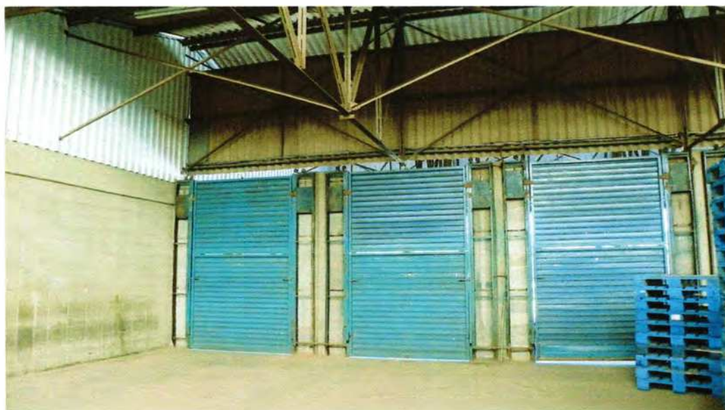
Foto 4. Portas das docas de carga e descarga
