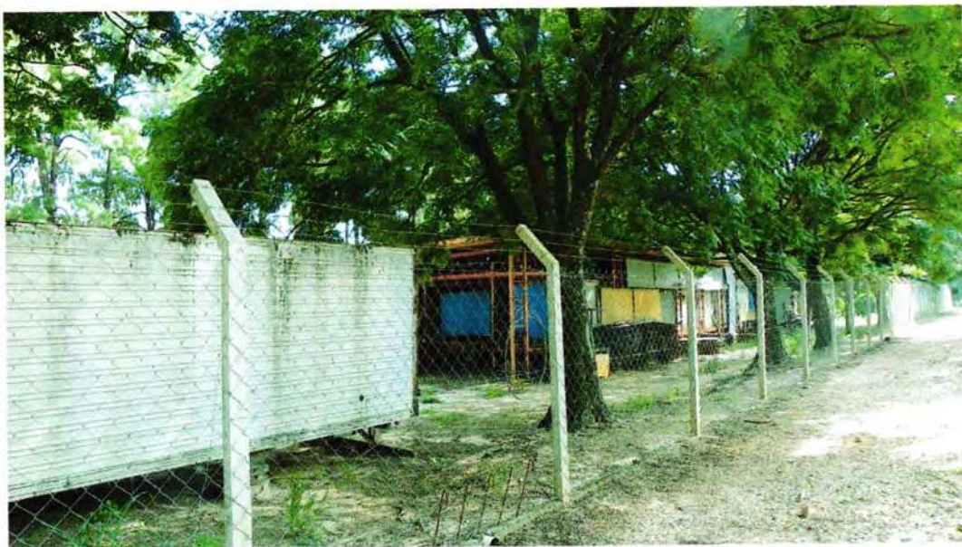
Foto 10. Cerca existente no imóvel isolando uma das áreas utilizadas pela GIGO para guarda de bens
