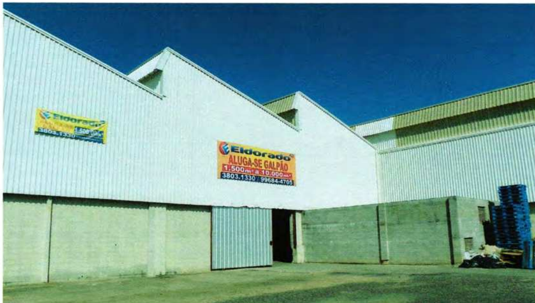
Foto 5. Vista parcial da fachada do galpão, do lado oposto às docas
