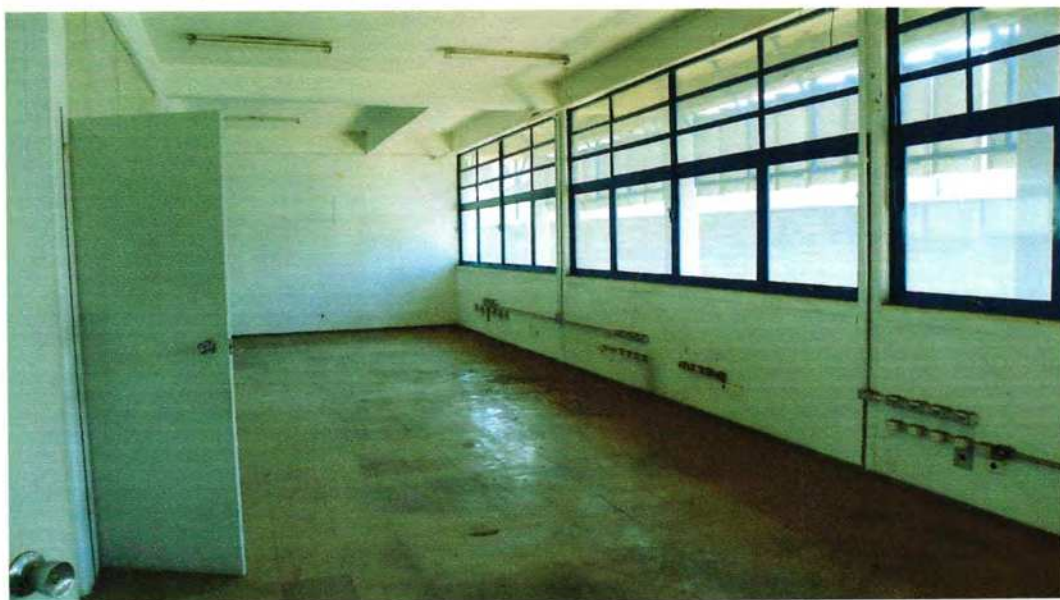
Foto 8. Sala desocupada na área administrativa
