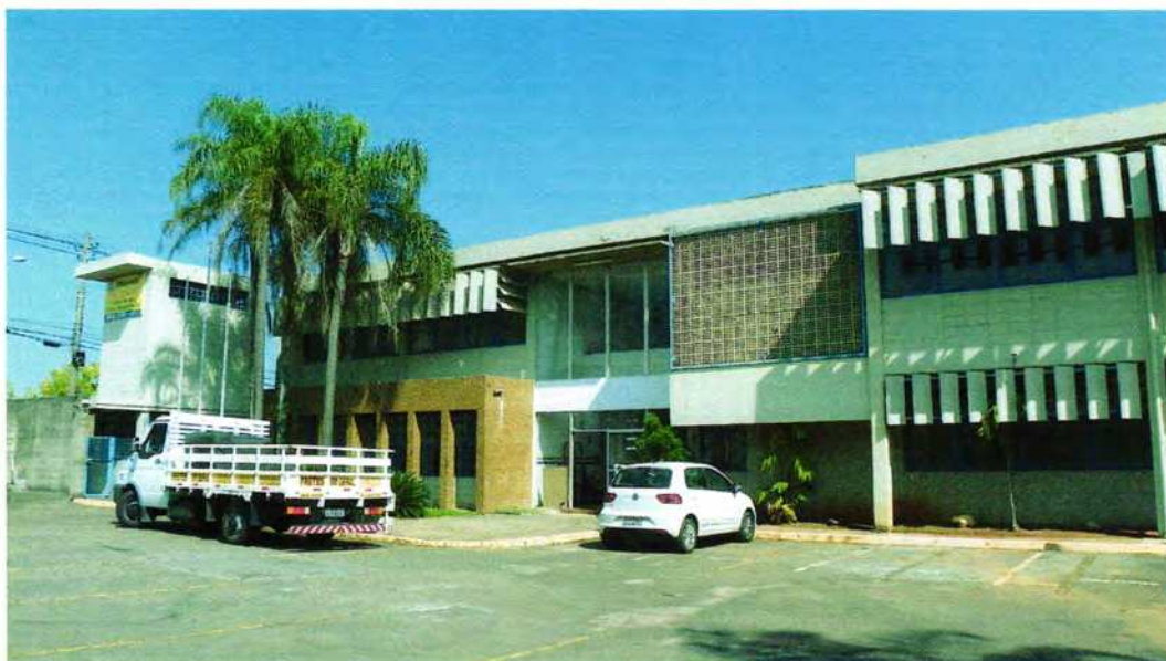
Foto 6. Vista parcial da fachada da área administrativa
