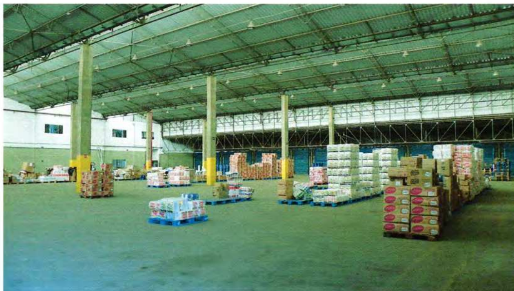
Foto 3. Vista parcial de área interna de galpão
